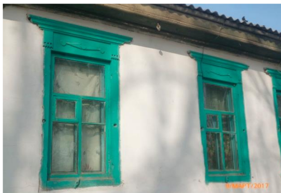
Рис. 1. Знак круга на оконном наличнике (г. Жаркент)
